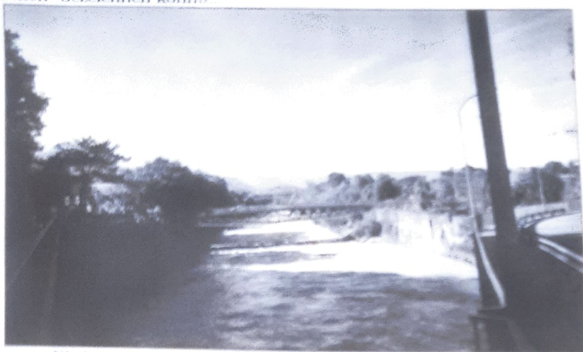
Blick von der Vereinigungsbrücke illabwärts zur Kapfbrücke
